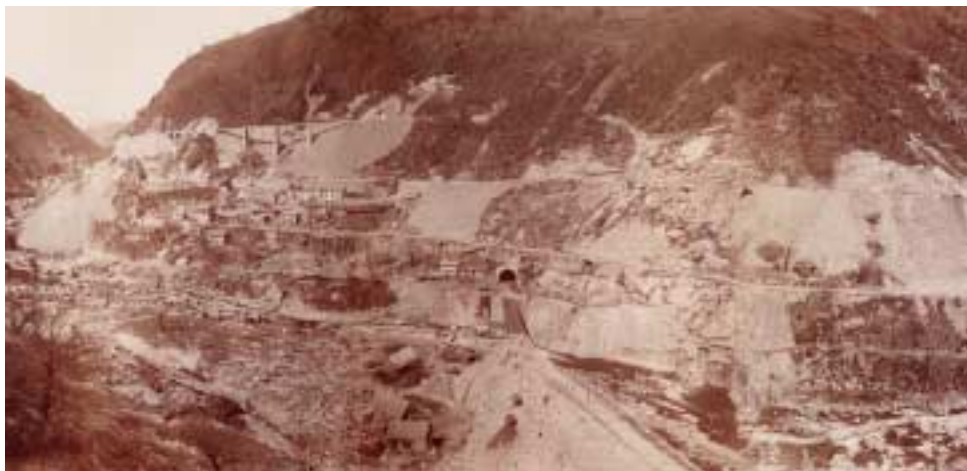
Der Bau der Tunnel, Brücken, Dämme schlugen in der Biaschina Narben in die Natur, die heute alle verwachsen sind. (VHS)
