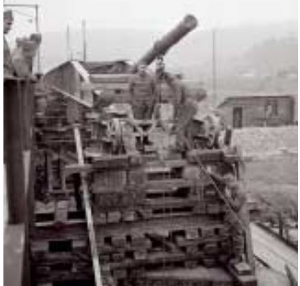
Aufbau Kriegsbrücke, 1941 zwischen Winterthur und Effretikon. (Historic)
