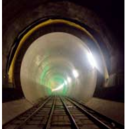
Aus Sicherheitsgründen besteht der Basistunnel aus zwei einspurigen Röhren. Tunnelröhre bei Bodio mit noch zwei Werkbahngleisen. (ATG)
