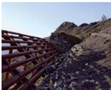
Nach den verheerenden Lawinnenniedergängen wurden die Anrissstellen aufwendig verbaut. (NB)
