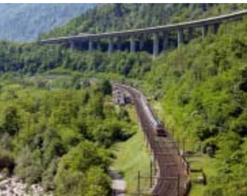
Der erste Bahnhof Giornicos stand weitab dem Dorf. Aus betrieblichen Gründen befand er sich am Fuss der zwei Kehrtunnel. (NB)
